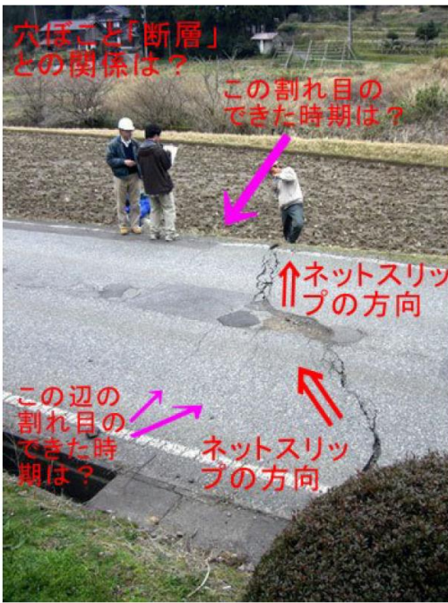
地山の縄文層と地すべり堆積物とを境する断層破碎帯(川辺ほか, 2007) 「断層」とされる道路の割れ目の写真(川辺ほか, 2007)
