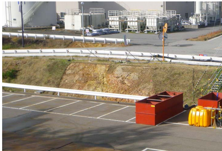
駐車場北側法面付近状況写真
