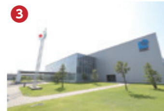
3 日本ガイシ NGK INSULATORS 日本ガイシ(株)石川工場
