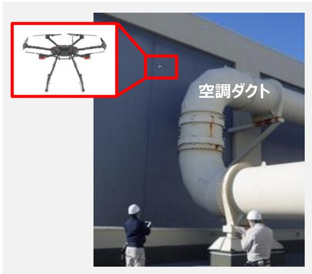
高所にある屋外空調ダクトの点検をドローンによる遠隔目視とすることで、直接目視のための足場設置作業を合理化。
