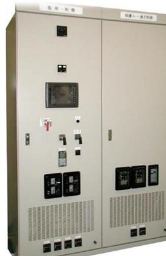
水車発電機制御装置
