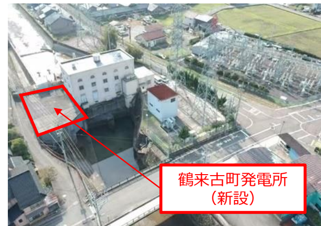
鶴来古町発電所
