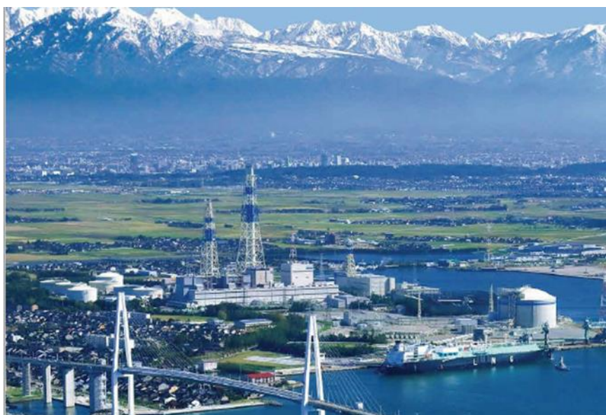
富山新港火力発電所
