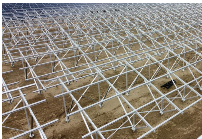
■再生アルミ材 使用箇所 (赤枠囲み)
