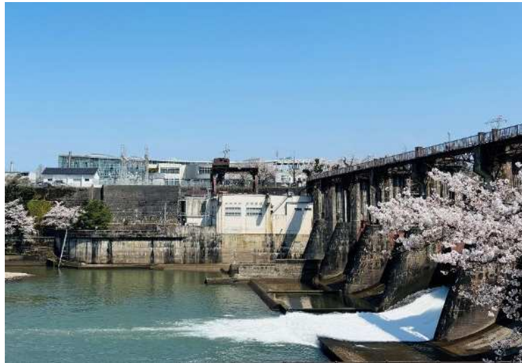
神通川第三発電所 全景
