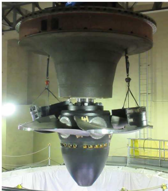
神通川第三発電所 水車ランナ
