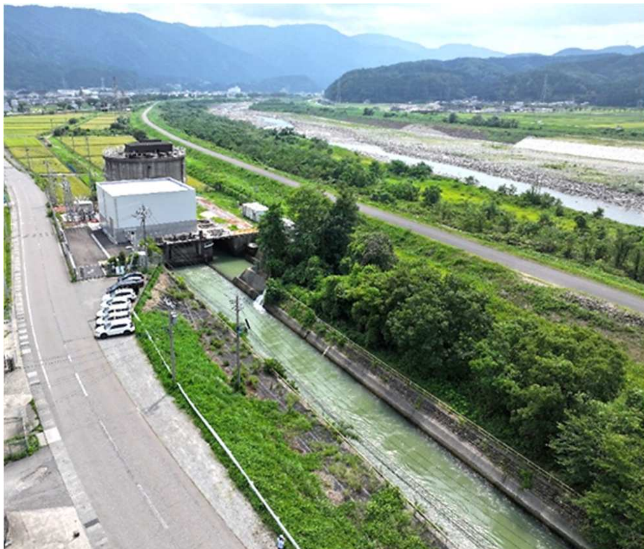
明島発電所 全景
