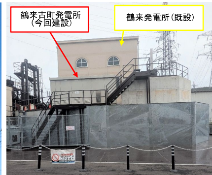
発電所全景（近景）
