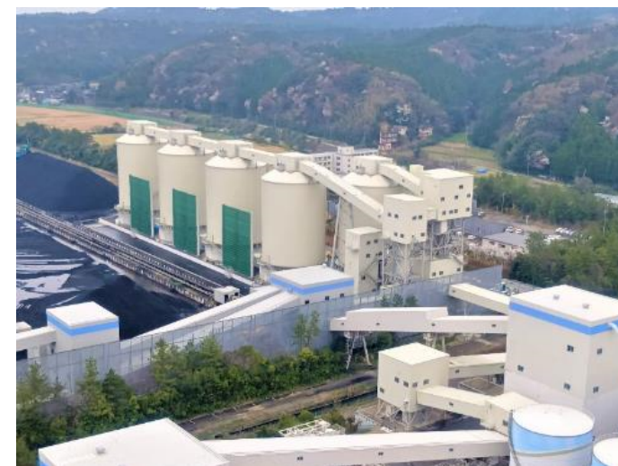
七尾大田火力2号機 バイオマス燃料貯蔵サイロ・運搬設備
