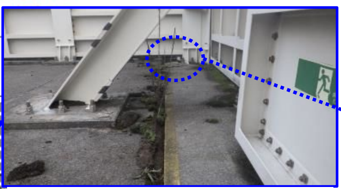
1号機 放水槽防潮壁 (内側)
