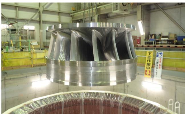
手取川第二発電所 水車羽根車（ランナ）
