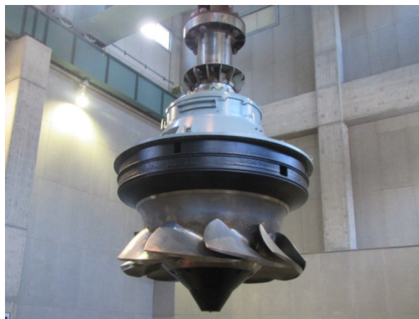
西勝原第三発電所 水車羽根車（ランナ）
