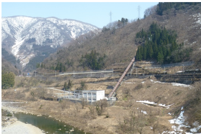
西勝原第三発電所 全景
