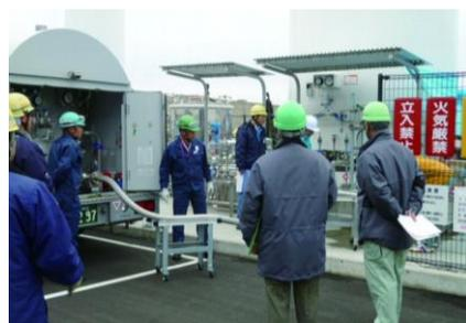
サテライト設備へのLNG荷卸作業
