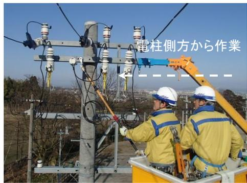
電柱の側方から改良型器具により施工
