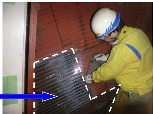
複数の配管を一体化したパネルで取替えを行うことにより、作業効率が向上。
