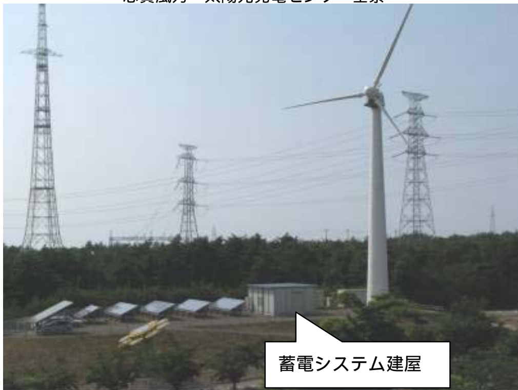
志賀風力・太陽光発電センター全景
