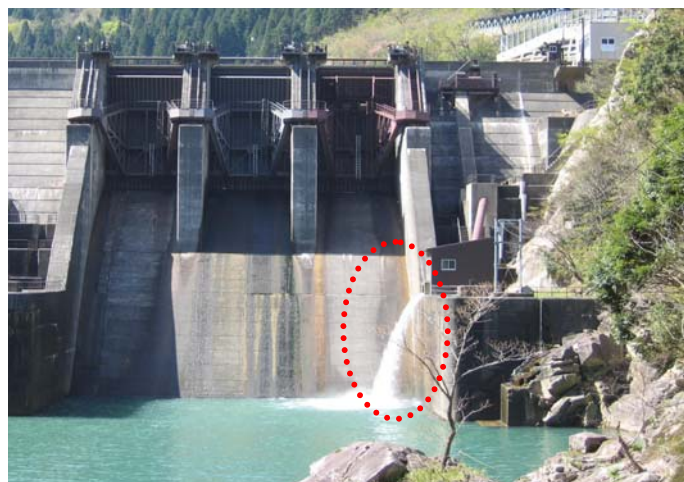
河川維持放流の状況(仏原ダム)
