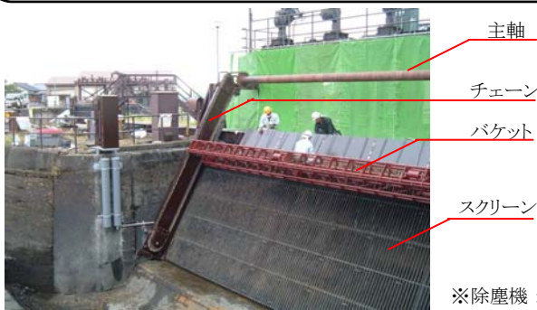
除塵機の取替作業
