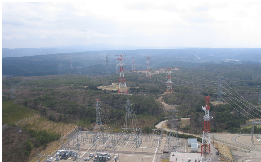
中能登変電所
