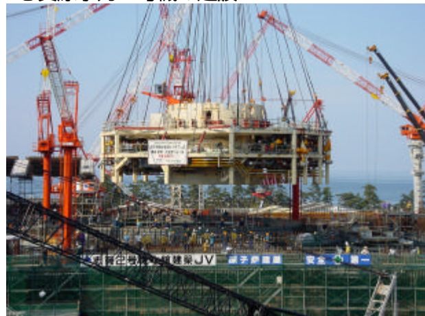
原子炉格納容器配管モジュールの吊り込み
