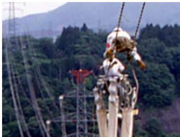
送電線保守作業
