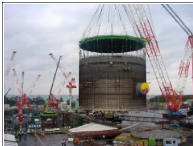
原子炉格納容器下部ライナ吊込み (H14.1.17)
