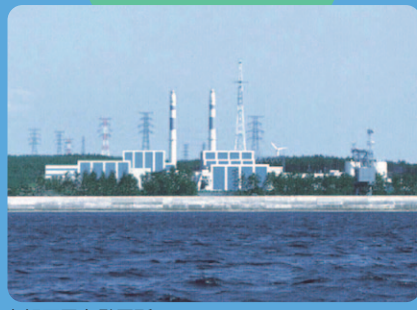
志賀原子力発電所
