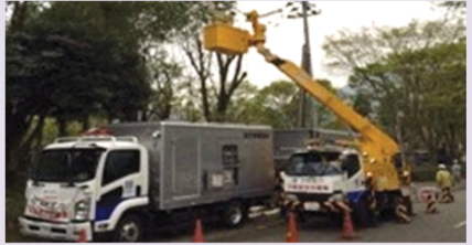
災害時の復旧作業
