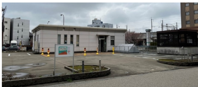
【参考】昭和町変電所の写真
