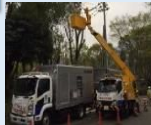
災害時の復旧作業
