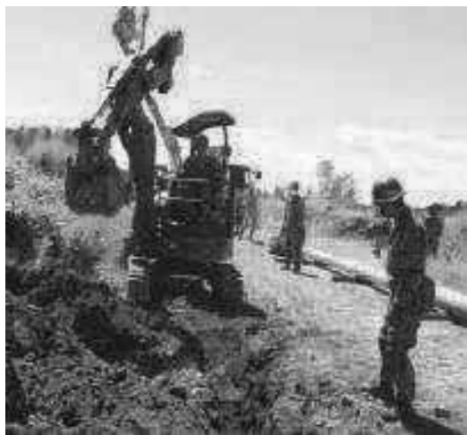
電柱建て込み場所の掘削作業
