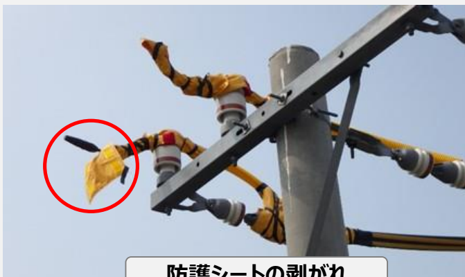
防護シートの剥がれ
