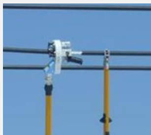
①電線被覆の剥ぎ取り
