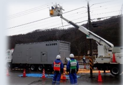
<大容量発電機車>
