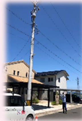
<停電回避に向けた設備巡視>
