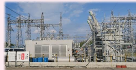
<微量PCB含有機器の加熱洗浄処理>
