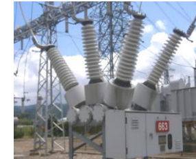
ガス遮断器 (66kV・77kV)
