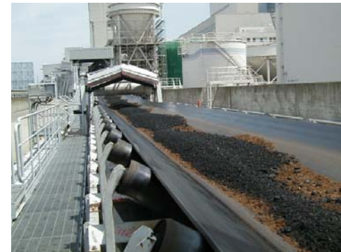
◆6/29より敦賀火力2号機において 木質バイオマス発電開始 (燃料[石炭+木質バイオマス]搬送状況)
