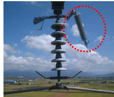
雷害対策（送電用避雷装置）
