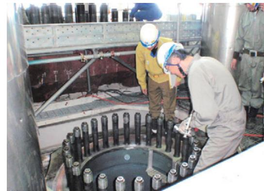
↑七尾大田火力2号機 タービン主要弁弁箱点検
