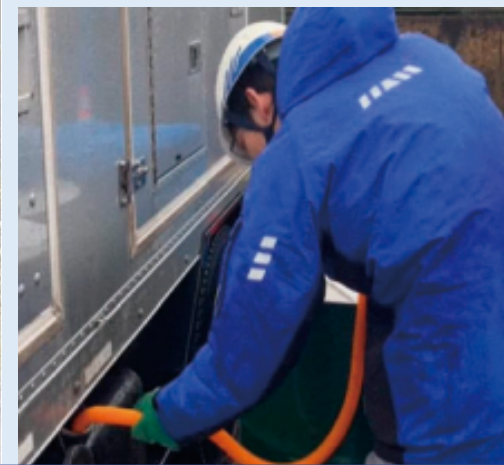
電源車への燃料給油
