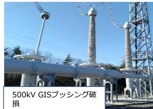
500kV GISブッシング破損
