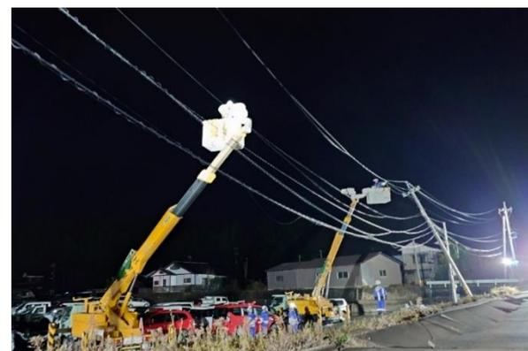
応急復旧工事（電柱傾斜改修）
