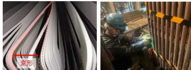
変形したボイラー配管と補修作業の様子
