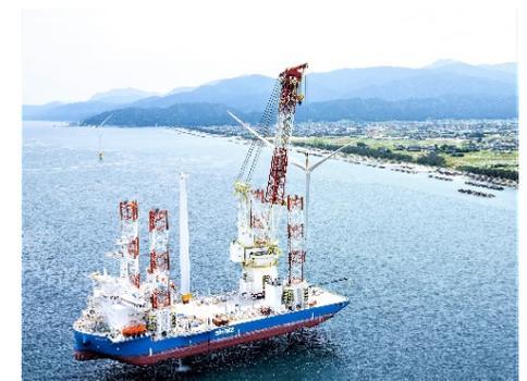
自己昇降式作業台船（SEP船）による海上施工の様子
