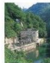
上寺津発電所
