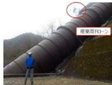
ドローンによる水圧鉄管の遠視点検状況（水力）
