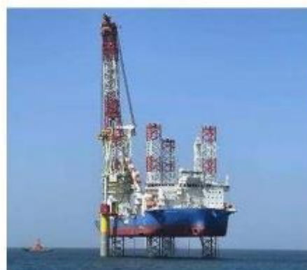
自己昇降式作業台船（SEF船）による海上施工の様子
