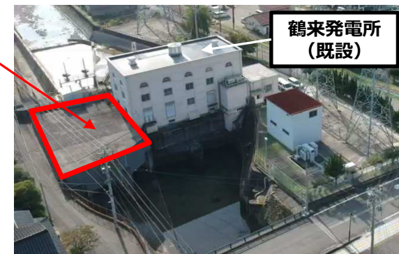
鶴来古町発電所の全景
