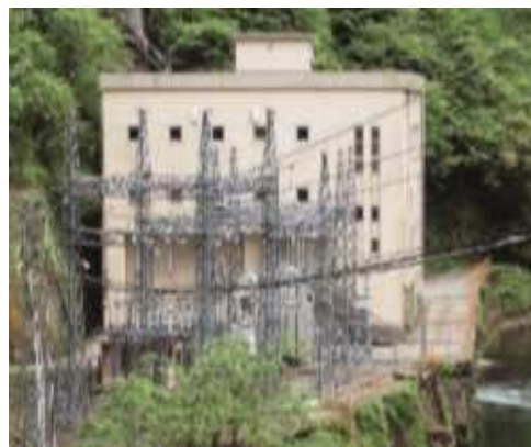
上寺津発電所
