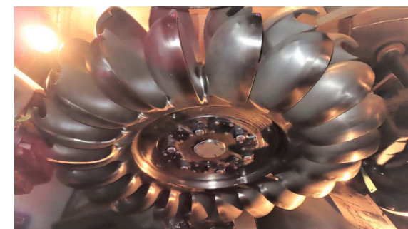
栃尾発電所ランナ（水車羽根車）
