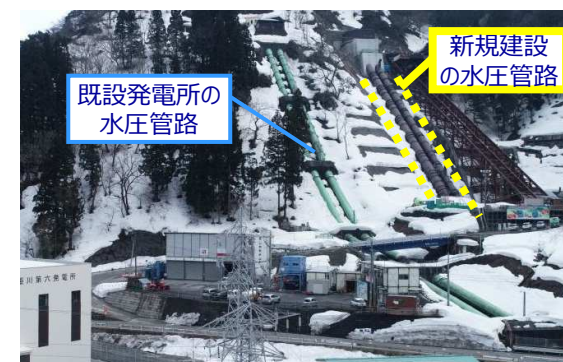
新姫川第六発電所
