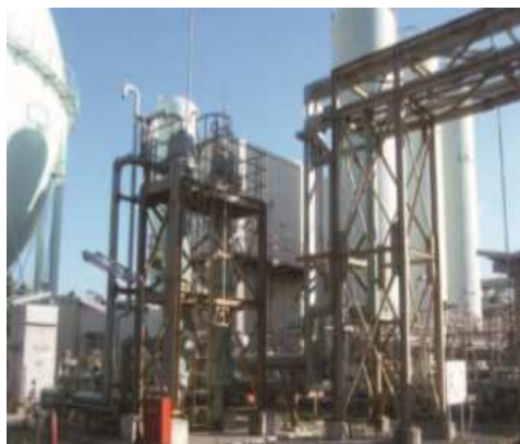
LNGサテライト
