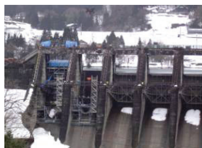
洪水吐ゲートの機能維持取替 (神一ダム:神通川第一発電所)
