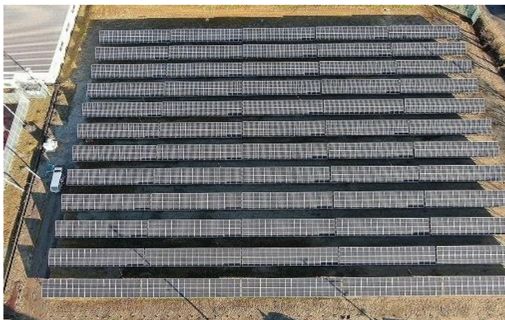
同社敷地内に設置した太陽光発電所 (1,024kW)
