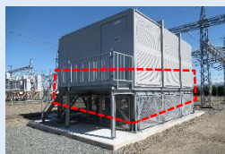
建物の嵩上げ
