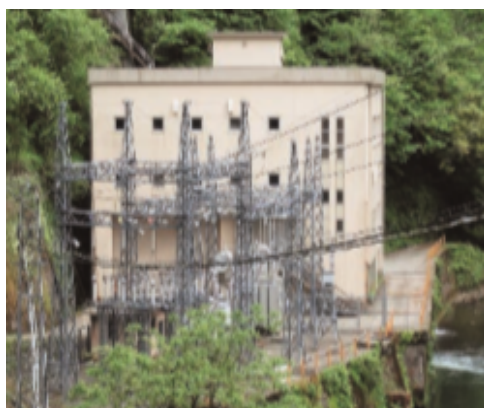
上寺津発電所
