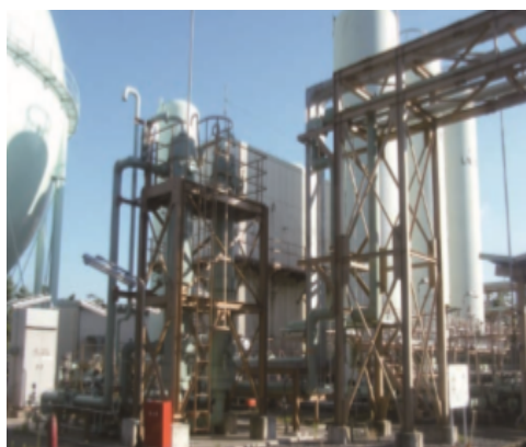
LNGサテライト
