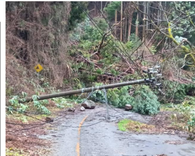
道路被害の様子。能登半島は山間部が多く道路が狭いため復旧作業への影響大
