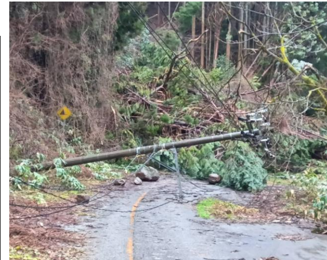
道路被害の様子。能登半島は山間部が多く道路が狭いため復旧作業への影響大
