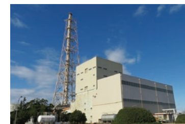
福井火力発電所
