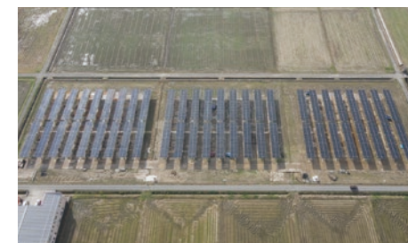
田んぼの上に設置された太陽光発電設備
