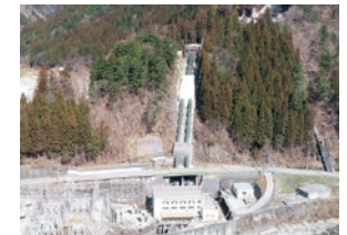
見座発電所の全景
