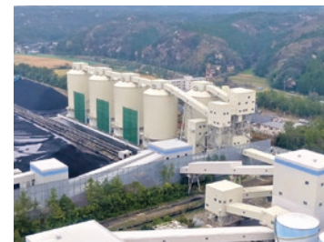
七尾大田火力発電所2号機 バイオマス燃料貯蔵サイロ・運搬設備
