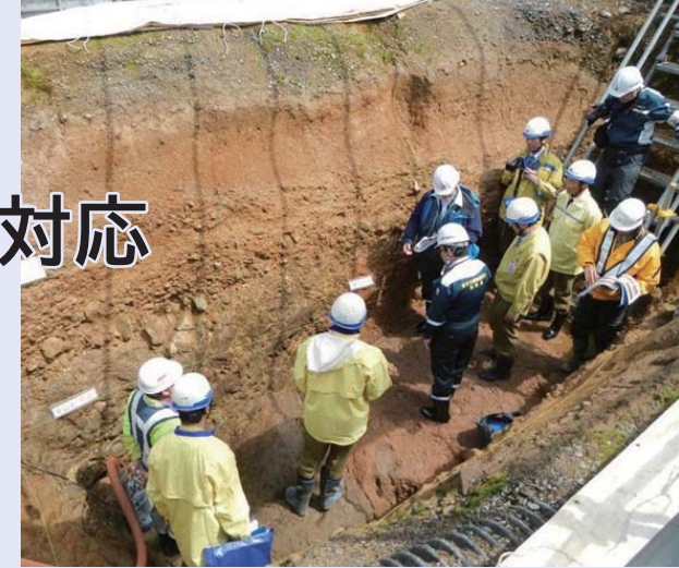
トレンチ調査の様子
