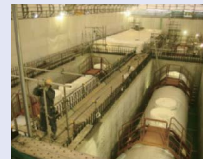
地下式軽油タンクの設置
