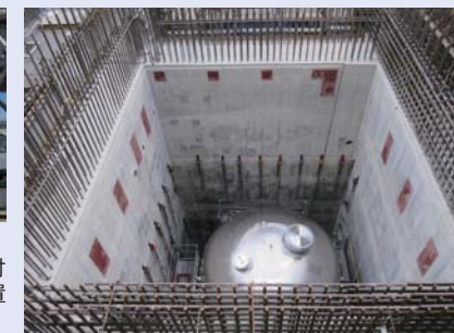
本体装置の搬入・据付（2015年7月）
