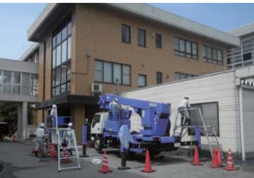
外壁のクリーニング
