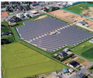
富山太陽光発電所
