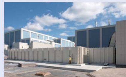
防波壁の設置
