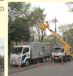
高圧発電機車の取付作業
