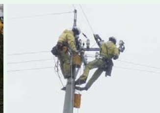
柱上での復旧作業
