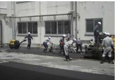
中庭の舗装作業
