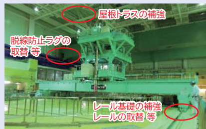
耐震安全性向上工事
