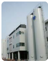
設備受託サービス (熱供給設備)
