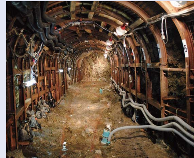
岩盤調査坑(横坑)
