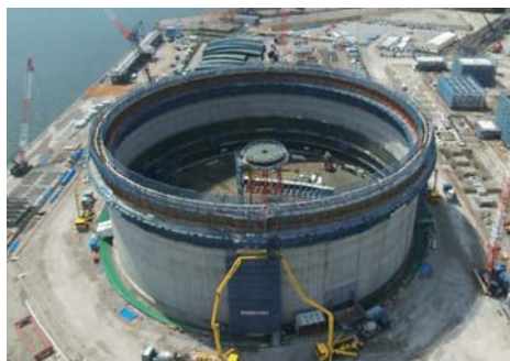
LNGタンク 工事
