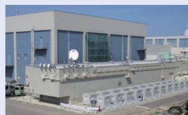
増築した指揮エリアの外観（増設緊急時対策所）
