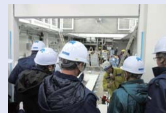
現地見学会の様子 （増設緊急時対策所の建設状況）
