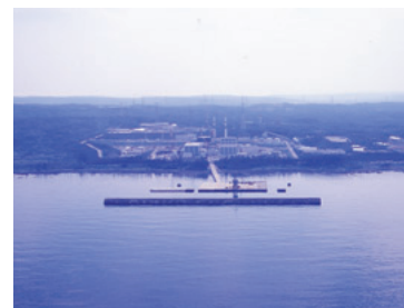
出島式物揚場
