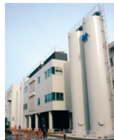
氷蓄熱式空調システムの蓄熱槽
