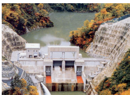
下流への放流状況(北又ダム)
