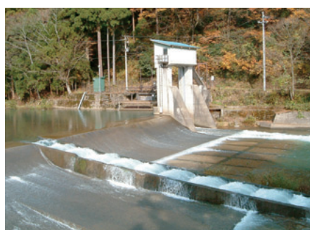
魚道設置状況(持越発電所取水ダム)
