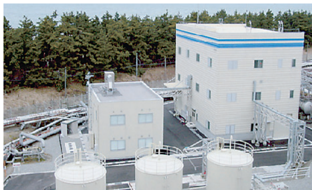
絶縁油リサイクルセンター全景
