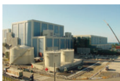
志賀原子力発電所2号機建設状況
