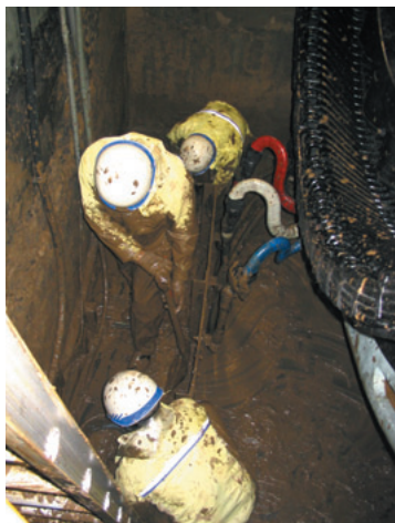
発電機の汚泥を取り除く復旧作業 (足羽発電所)
