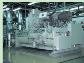
蓄熱式ヒートポンプ
