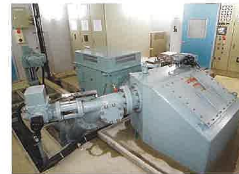
▲有峰ダム発電所内部 河川への維持放流水を活用した水力発電所
