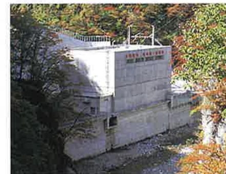
▲有峰第一発電所 単機出力(26.5万kW)が日本で最大の一般水力発電所
