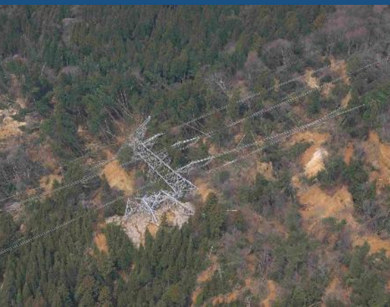
能登幹線鉄塔倒壊
