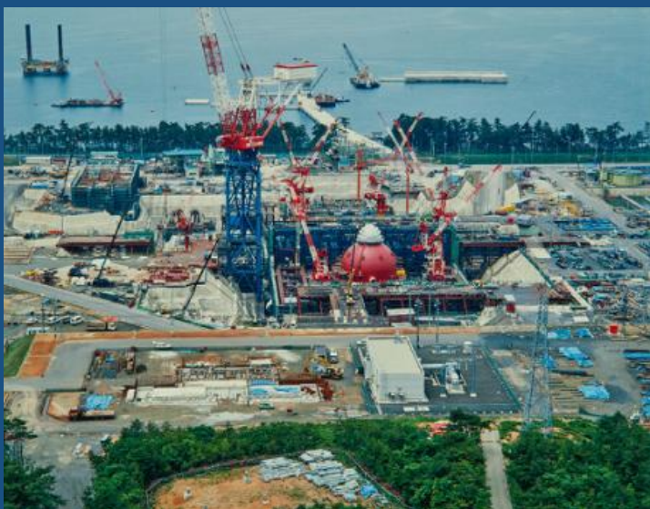
志賀原子力発電所1号機 建設工事
