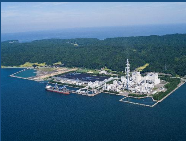
七尾大田火力発電所
