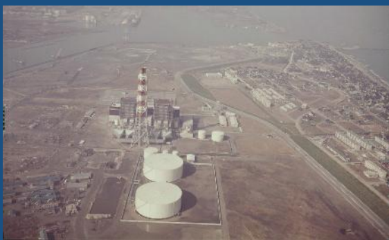
富山新港共同火力発電所
