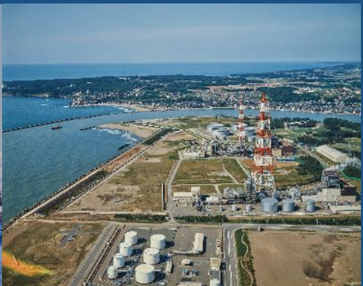
三国共同火力発電所1号機
