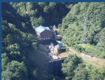
小口川第三発電所と真立ダム
